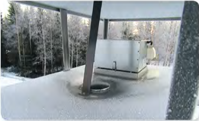
Tarkastettavana huoneiston ilmastointilaitteita rakennuksen katolla.
